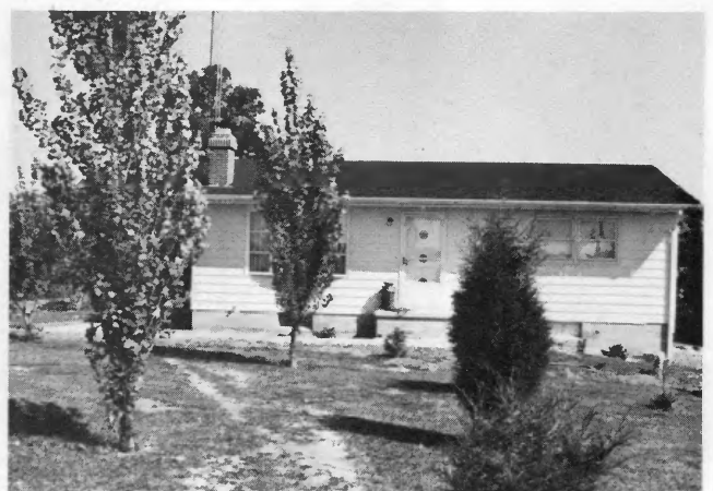
Donald Beckett R. R. 1, Sullivan, IL Electric Furnace
